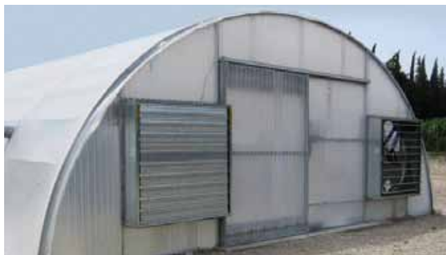
Pignon semi-rigide équipé de 2 extracteurs d'air et d'une porte coulissante de 1,60 m
