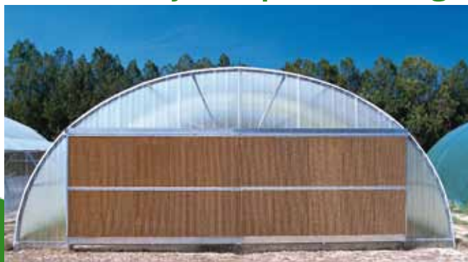
Pignon équipé d'un pad de 6 m x 2 m
