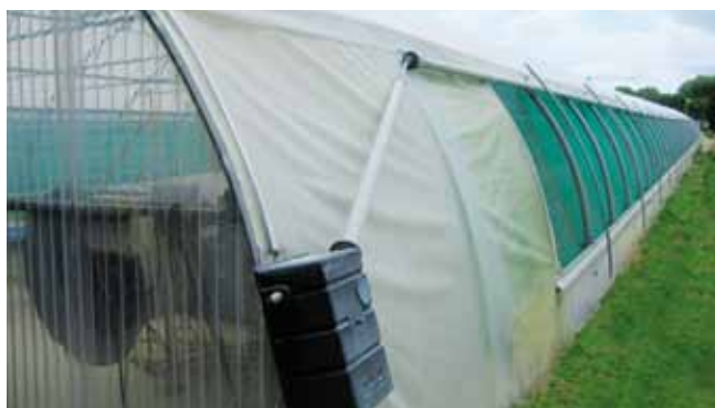
Ecartement des bâches par câble et treuil mécanisé
