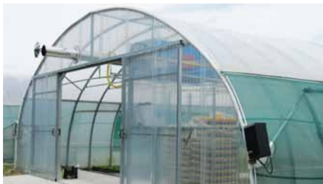
Pignon portes coulissantes (3,20 m). Habillage semi-rigide PVC
